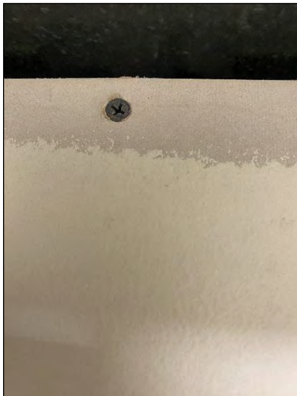
HA 08 – Sheetrock, Wall, “No Asbestos Detected”
