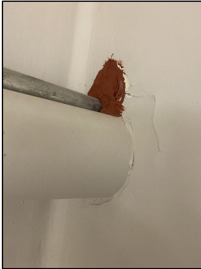
HA 14 – Red Firestop, “No Asbestos Detected”
