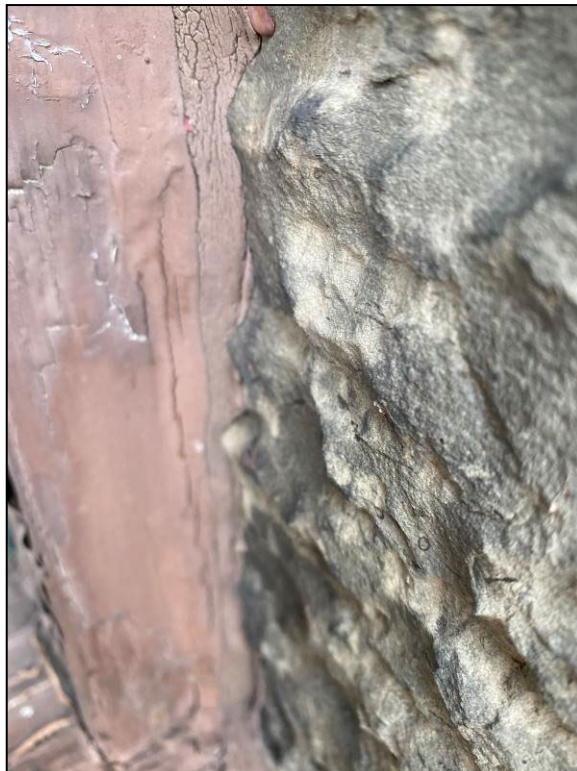
HA 04 – Window Frame Caulk, “No Asbestos Detected”
