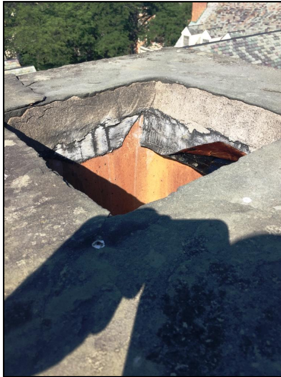
HA 09 – Chimney Flue Mortar, “No Asbestos Detected”
